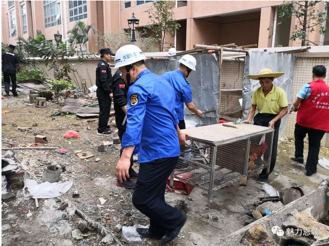
工作人员清拆占道搭建的鸡舍
