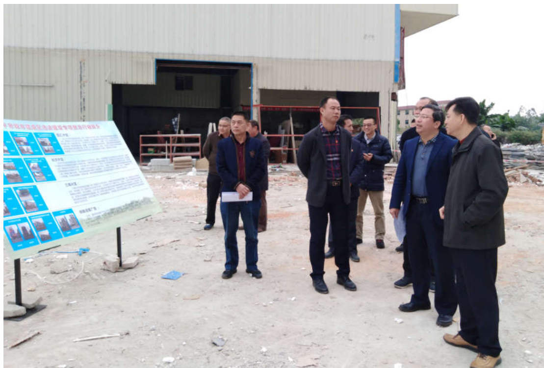
督查省道 274 线科技路路段的违法建设拆除现场
