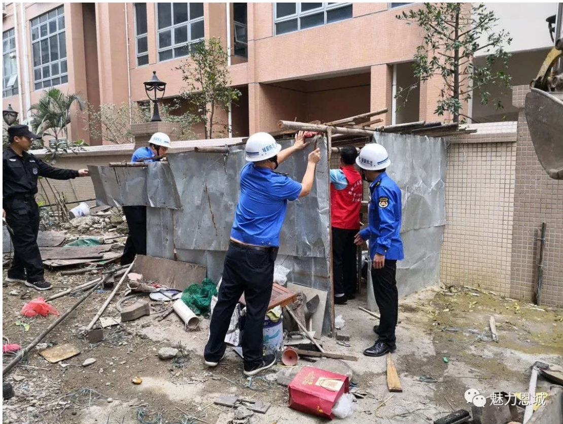
工作人员清拆违章搭建的雨棚
