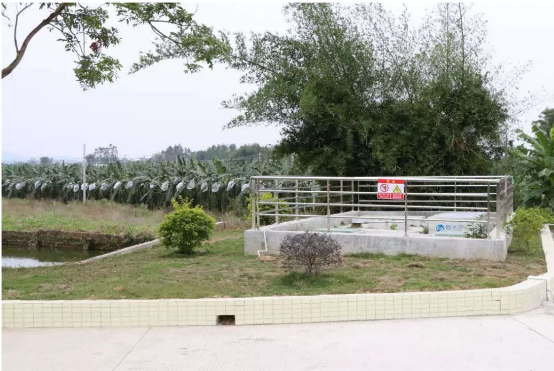
▲ 污水处理工程
