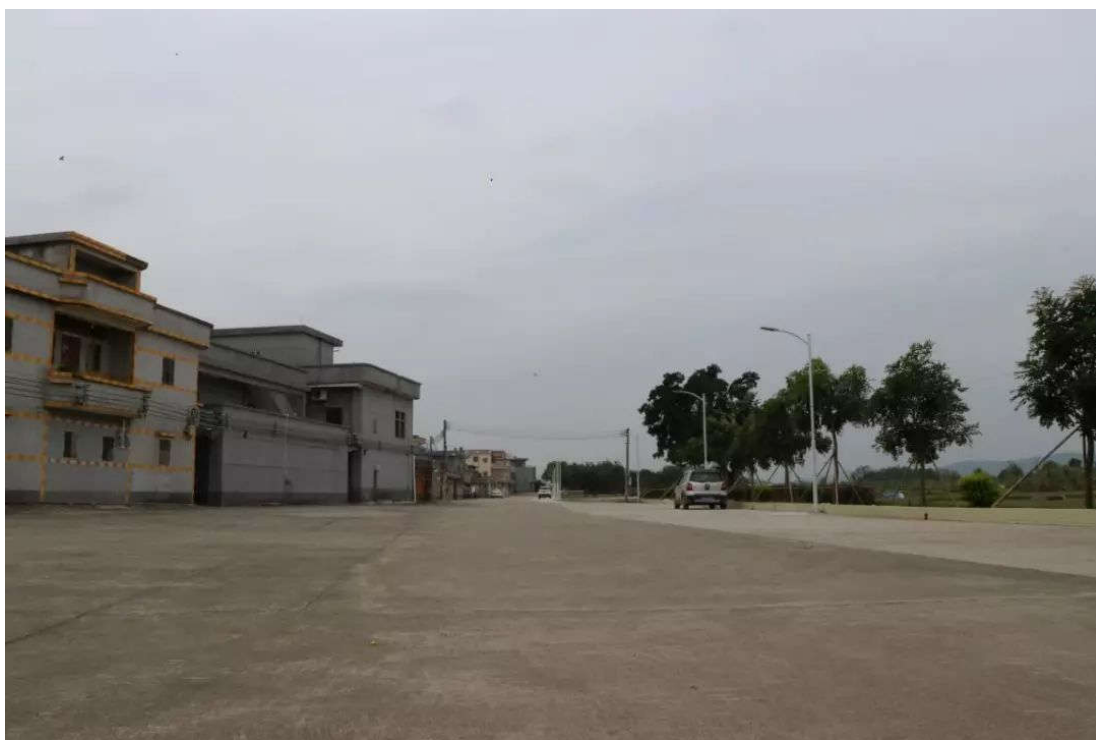
▲塘坦硬底化捣制工程
