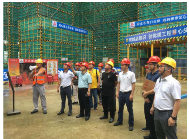
恩平市住建局检查泉林黄金小镇三期项目
