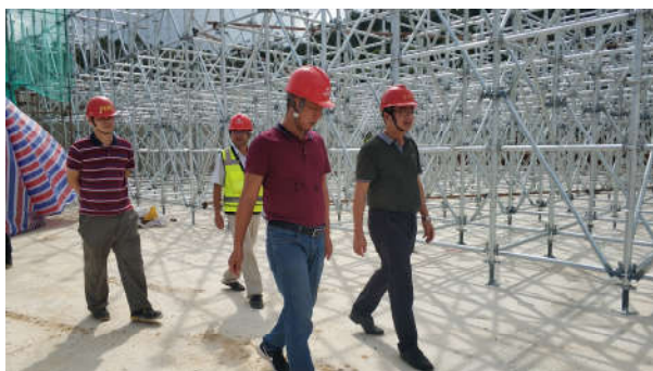
江门市住建局检查江门市南山路（江海路-五邑路）-道路工程
