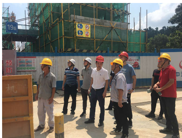
恩平市住建局检查佳源帝都温泉山庄一期项目
